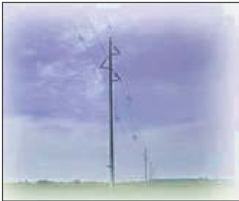
Fig. 3.2. Un palo di sostegno con visibilità aumentata grazie all'applicazione di spirali (particolare in fig. 3.3)
