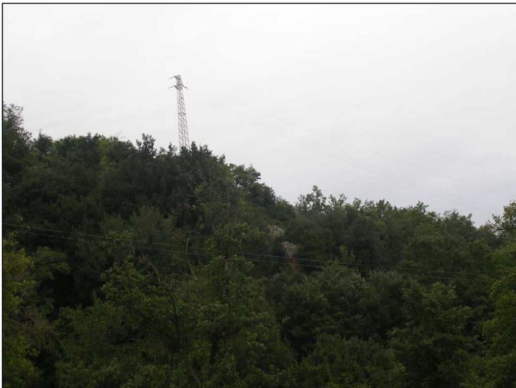
Foto 20. Linee elettriche AT che attraversano il vallone all’interno del pSIC/ZPS, fattore di minaccia per le specie di Rapaci di interesse comunitario che frequentano l’area per la nidificazione e per scopi trofici.
